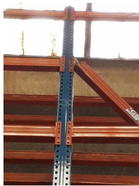
Figura 25 — Cisalhamento na solda
